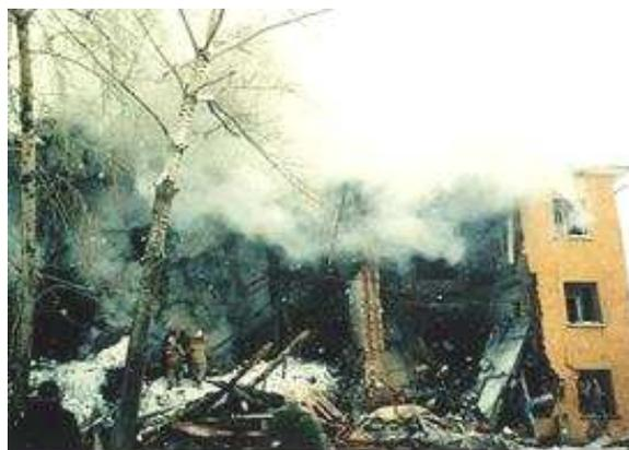
**Рис.3. Последствия взрыва пропана в квартире (первый этаж) трехэтажного жилого дома (г.Бийск).**
