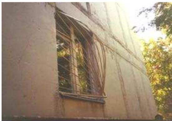
**Рис1. Остаточный прогиб оконной решетки после взрыва в квартире.**
